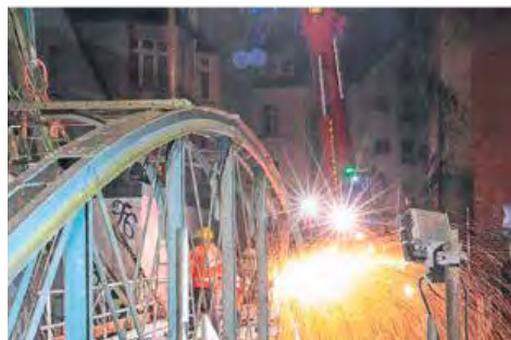
Der Pfälzer Steg, hier ein Bild vom Abriss 2019, soll neu gebaut werden.
