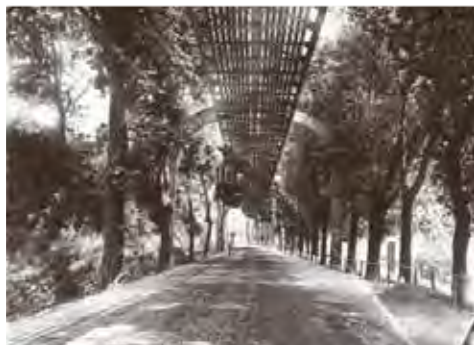
Die Schwebebahn in Hammerstein: Dieser Streckenabschnitt wurde ab Mai 1901 mit Fahrgästen befahren.
