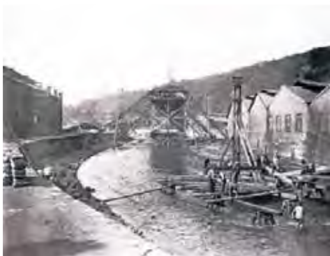
Der Bau der Fundamente zwischen Zoo und Varresbeck.
