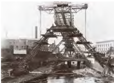
Arbeiter auf dem Schwebebahngerüst an der Alexanderbrücke.
