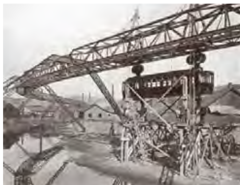
Bereits 1898 wurden die ersten Probewagen in Varresbeck ans Gerüst gehängt.
