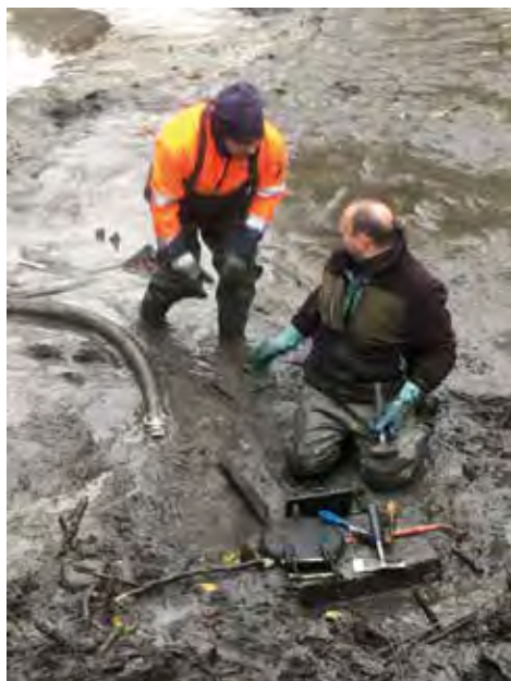
Die Entfernung des Schlammes war eine große logistische Leistung, ebenso das Betonieren des neuen Bodens.
