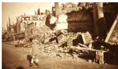
Kriegsschäden, Gewerbeschulstraße ca. 1943 Foto: Stadtarchiv Wuppertal
