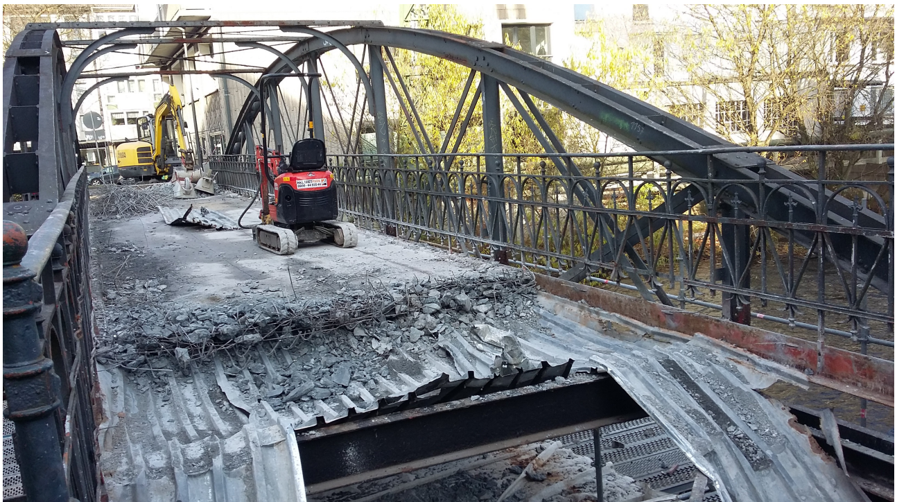
Abriss der Brücke Pfälzer Steg (Foto: Wiebel/HBV)
